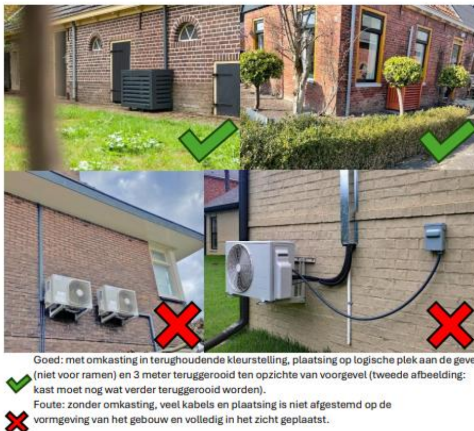
Figuur 6: regels plaatsing warmtepompen in beschermde gezichten (bron: Welstandsregels voor zonnepanelen en -collectoren & buitenunits warmtepompen, airco's en thuisbatterijen)
