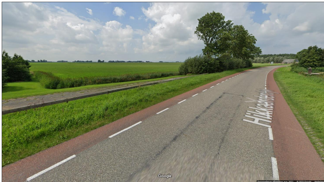
Schermafbeelding 1. Vanaf de Hikkaarderdyk richting het noordwesten. Bron: Google Streetview, augustus 2021
